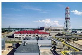
Рисунок 8.4 - Пример территории котельной и некоторого ее оборудования
