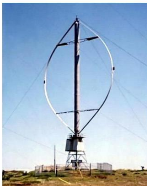
Рисунок 3.4 - Ветроустановки с горизонтальной (а) и вертикальной (б) осью вращения
